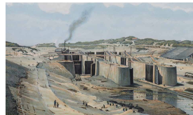
Bouw van de sluizen in IJmuiden www.noord-hollandsarchief.nl
