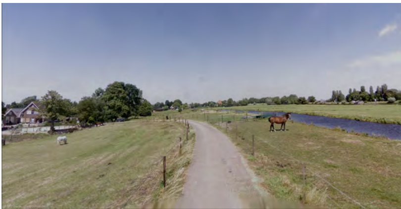
▲ Bovenkerkerpolderdijk geen doorlopend pad
