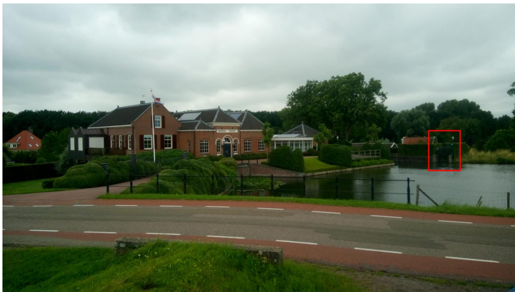
Afbeelding 6. Voormalig gemaal Katwoude en huidige inlaat (rood kader)
