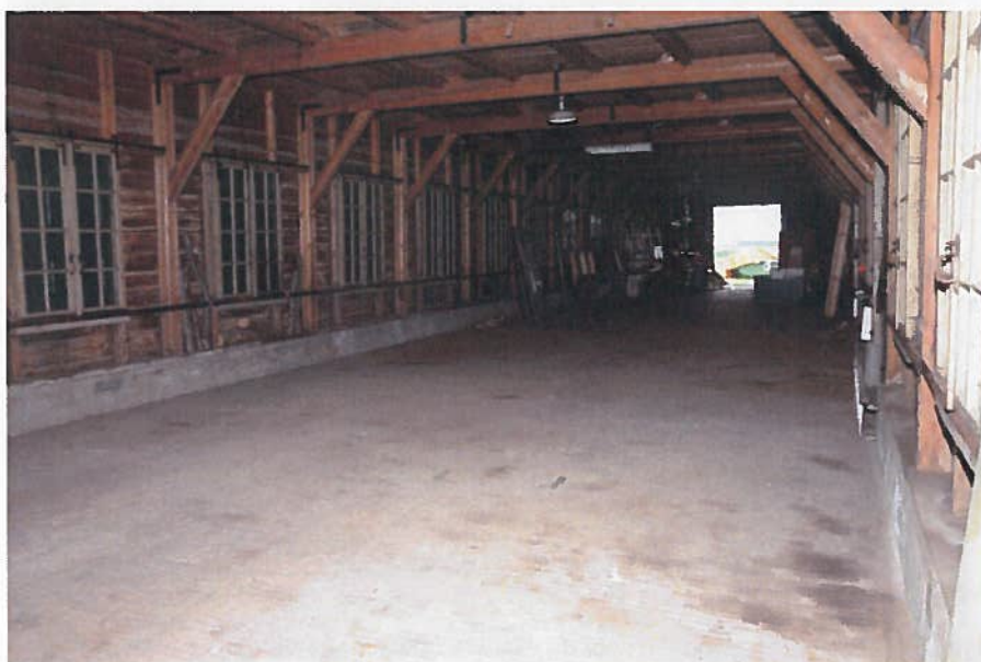
afb.2.4 interieur genielloods (bron: Stadsherstel NV)
