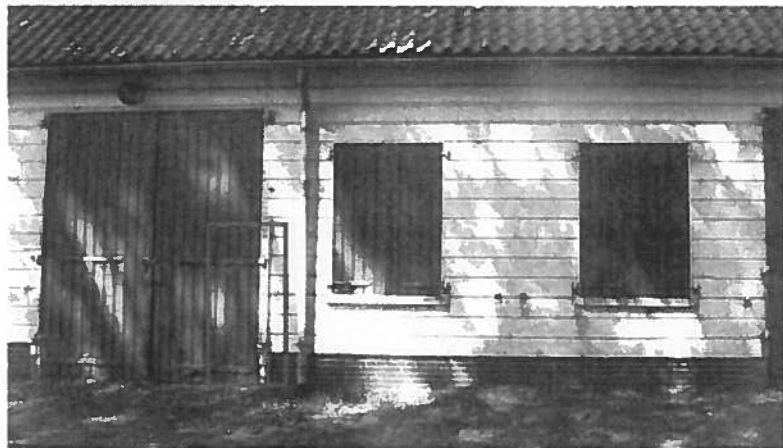
Foto 6, Deur in zijgevel
