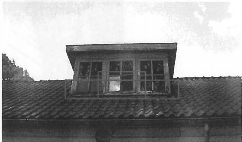
Foto 9; Dakkapel aan de linker zijgevel
