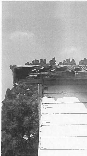
Foto 12; Dakgoot rechterkant achtergevel
