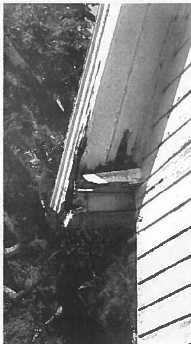
Foto 7; Waterbord aan de achtergevel
