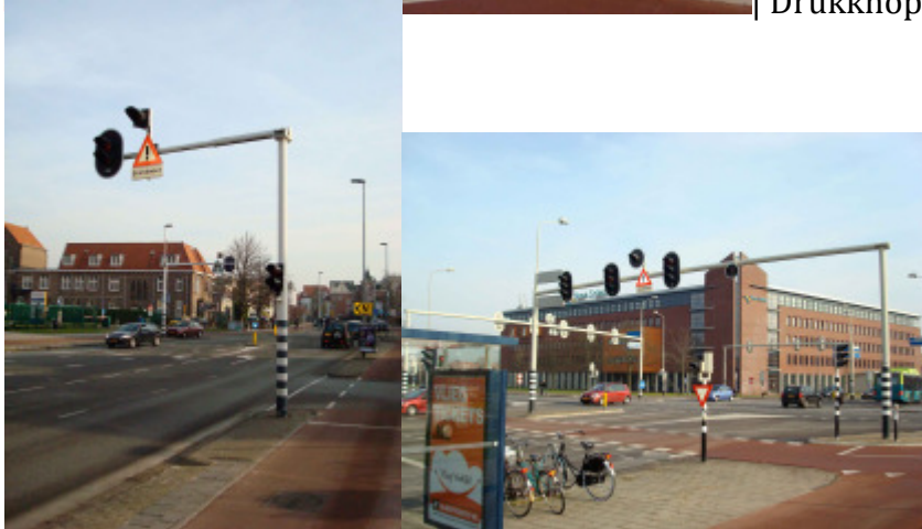
| Zweepmast, bestaat uit 1 mast en een uitlegger_portaal - Portaal, bestaat uit 2 masten en een uitlegger_portaal|
