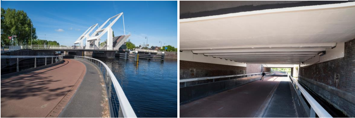
Afbeelding 5.7 Fietsonderdoorgang bij Buitenrustbrug in Haarlem (bron: collectie Witteveen+Bos)
