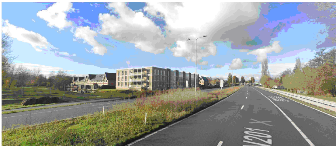
Situatie gezien vanuit Heemstede richting Cruquiusbrug (Bron: Google, jan2022).
