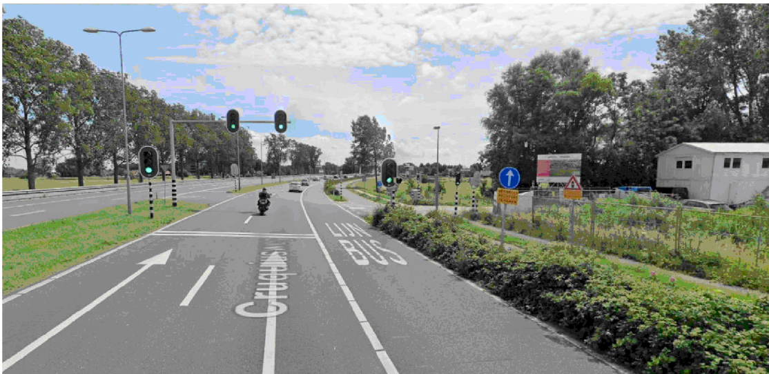
Tijdelijke VRI, gezien vanuit Heemstede richting Cruquiusbrug (Bron: Google, juli 2020).
