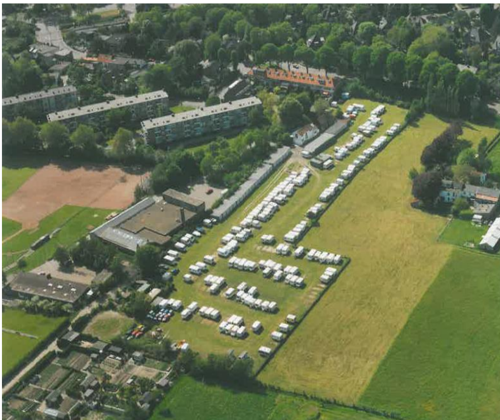
Figuur 6: Oude situatie met caravanstalling en bedrijfsbebouwing
