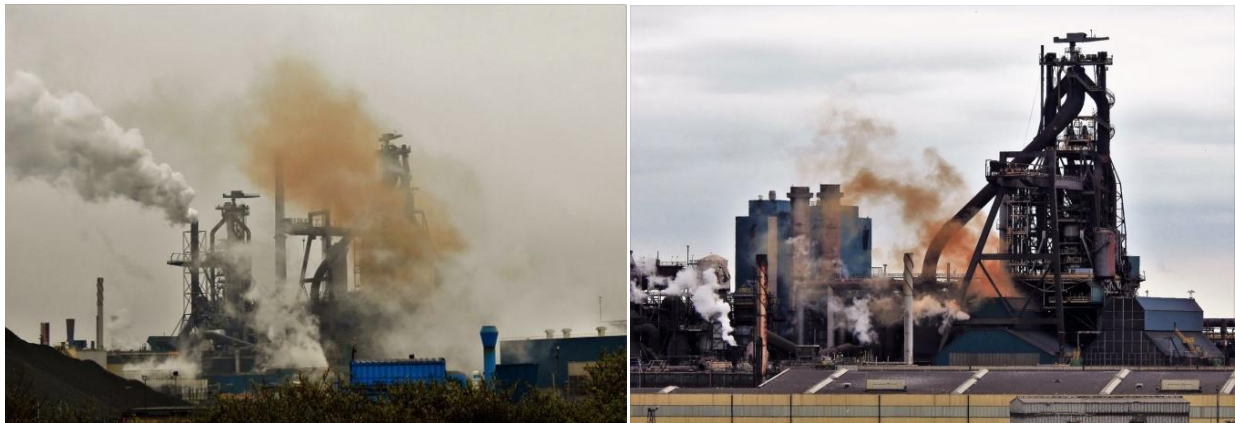
Ventilatie van ontstoffingshuis (hoogoven) naar buitenlucht
