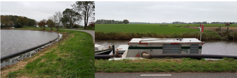
Foto 2 en 3: voorbeelden van leidingen (links) en een booster (rechts)
