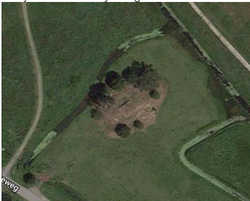
Bunker deelgebied C1
