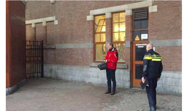
De donkere, vuile nissen rond het stationsgebouw vormen geen prettige plek om te wachten op de bus
