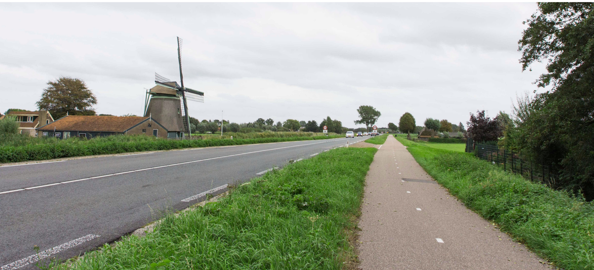
A.C. de Graafweg (N241) op ringdijk Heerhugowaard met zicht op molen 'De Hoop'
