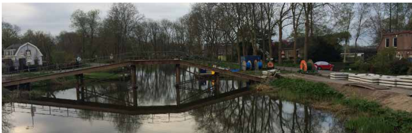
Tijdelijke brug kabels en leidingen over Gein.
