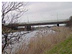
Brug A10 Rozenburgbrug, Amsterdam
