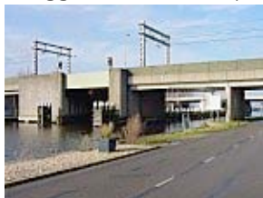
Spoorbrug Kaag, Haarlemmermeer
