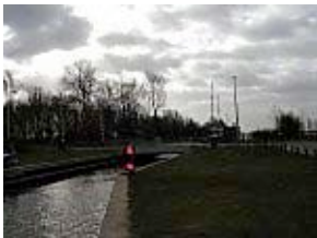
Zanderijbrug (N523), Weesp
