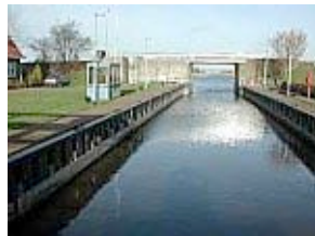
Brug Braaksluis, Niedorp
