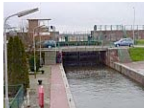
Brug Overlekersluis, Medemblik
