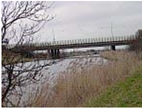
Brug A10, Amsterdam
