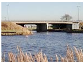
Brug 't Schouw, Waterland
