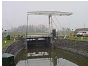
Brug Kloosterdijksluis, Waterland
