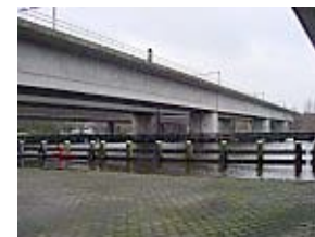
Spoorbrug A10, Amsterdam
