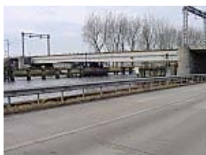
Spoorbrug Purmerend, Purmerend
