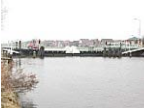
Vlotbrug 't Zand, 't Zand
