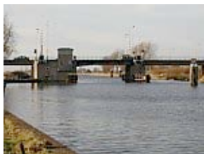
Kogerpolderbrug, West Grafdijk
