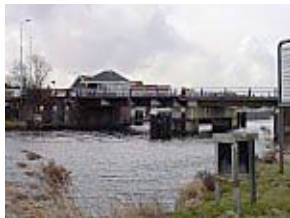
Brug Oude Wetering, Haarlemmermeer
