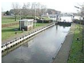
Brug Roskamsluis, Langedijk
