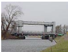
Bolbrug (spoorbrug), Langedijk
