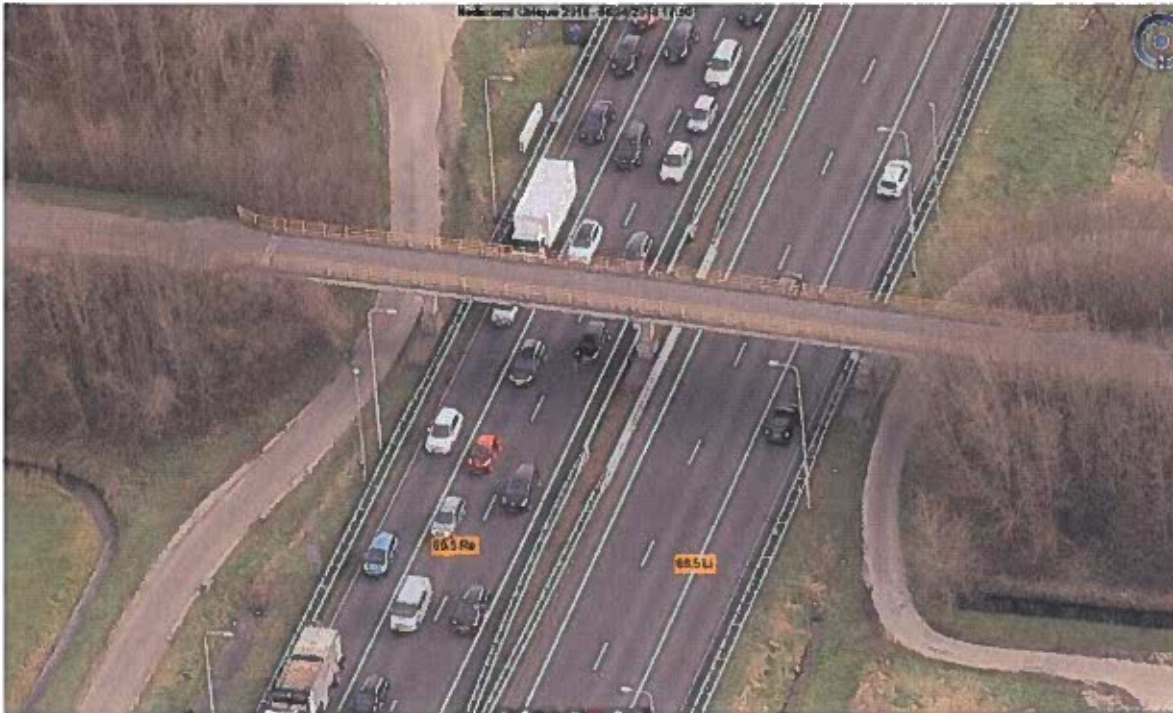
Figuur 2 Huidige situatie viaduct Kooibrug waar de bomen gekapt worden.
