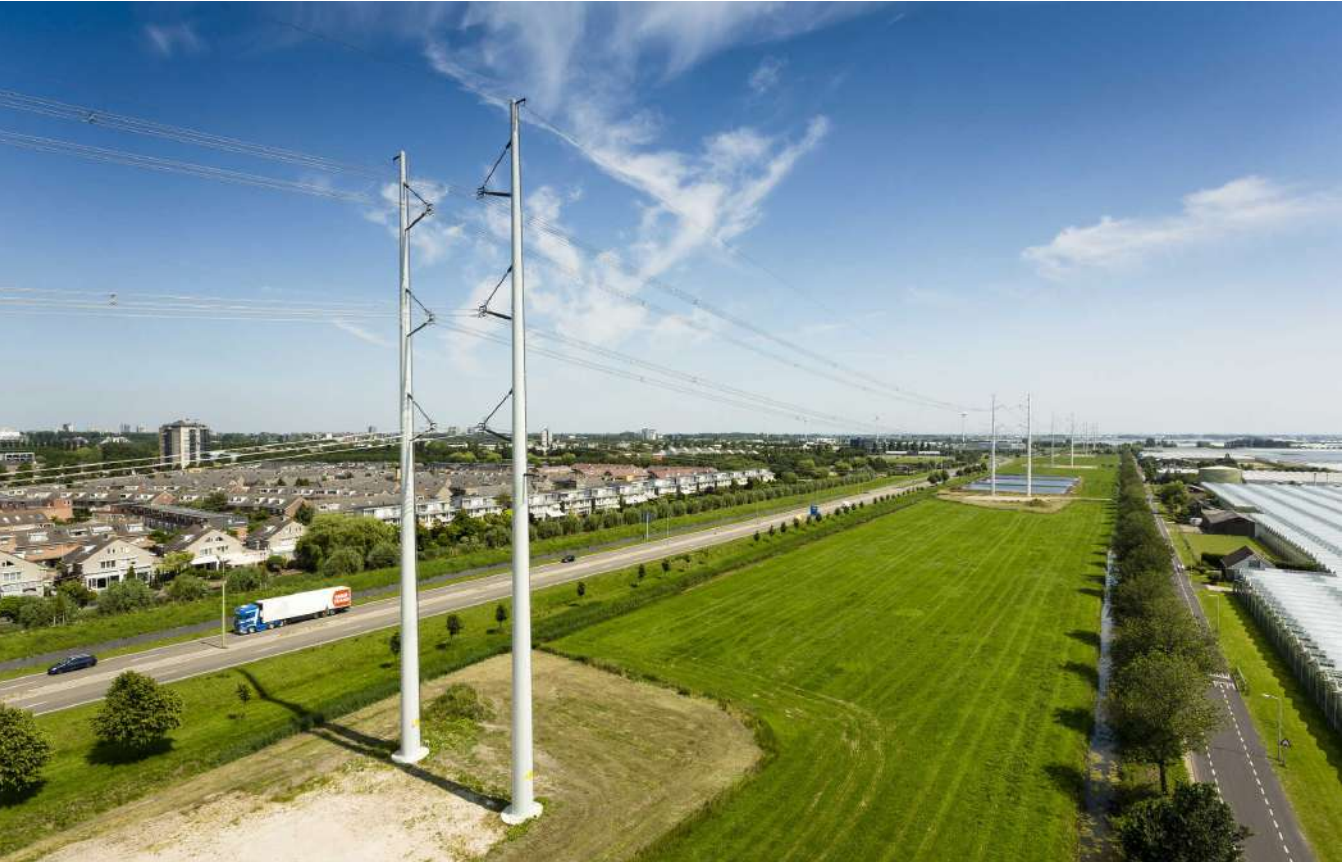
De Wintrackmasten hebben een modernere uitstraling dan de traditionele vakwerkmast. Bron: https://www.zja.nl/nl/Wintrack-masten
