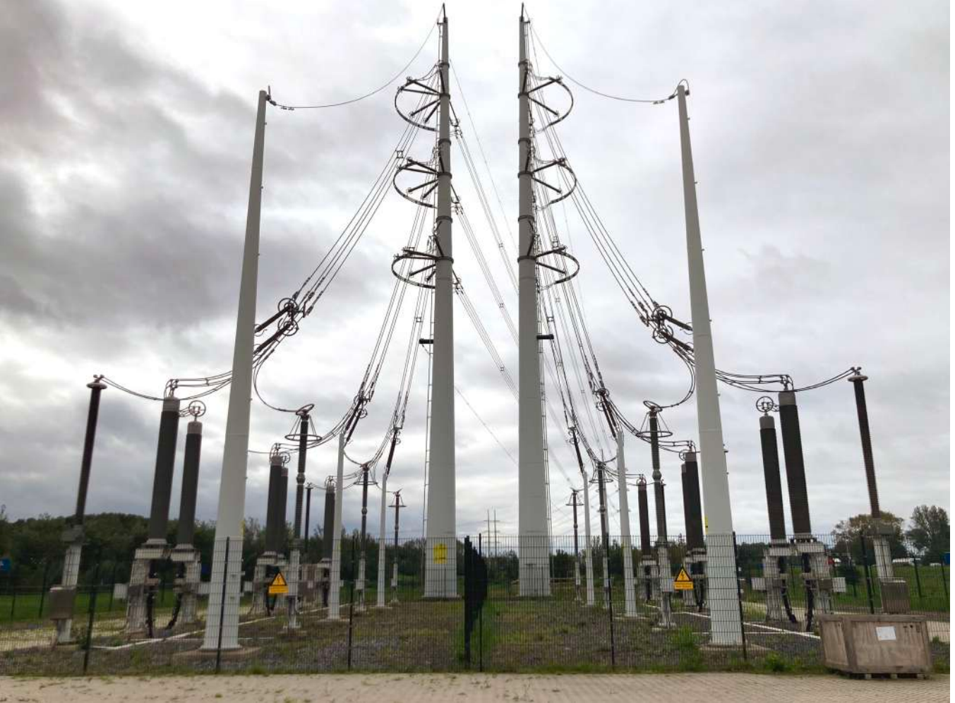
380 kV-opstijgpunt Velsen-Zuid vanaf de Heuvelweg om het bestaande 380 kV hoogspanningstracé van de verbinding Beverwijk – Vijfhuizen ondergronds aan te brengen (als ondergrondse oversteek van het Noordzeekanaal)
