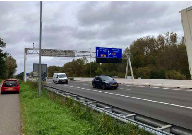
Het gebied kent vele grootschalige infrastructurele doorsnijdingen waaronder de A9
