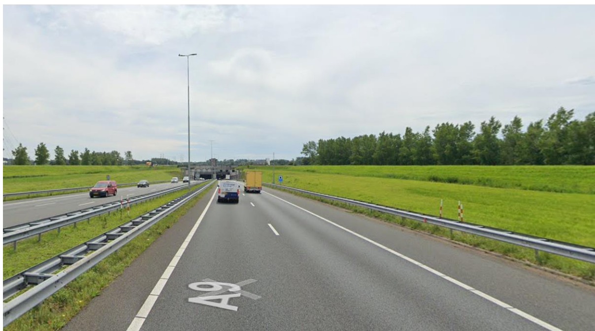
Figuur 10: Projectlocatie 16: op de vlakke delen naast de tunnelmonden van de Wijkertunnel worden zonnepanelen aangelegd
