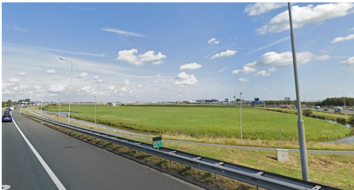
Figuur 9: Projectlocatie 36: in de oksel van knooppunt Hoofddorp worden zonnepanelen in een veldopstelling aangelegd (bron: Google streetview)
