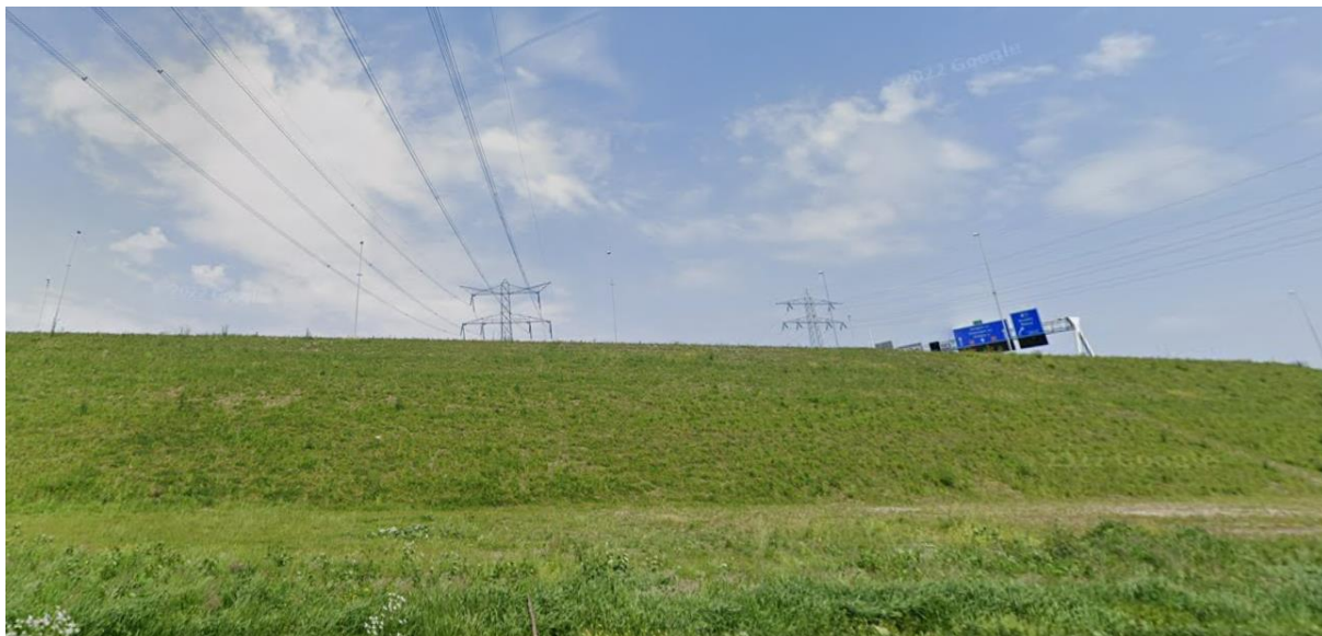
Figuur 4: Projectlocatie 87: zonnepanelen worden aangelegd op de taluds bij knooppunt Diemen (bron: Google streetview)
