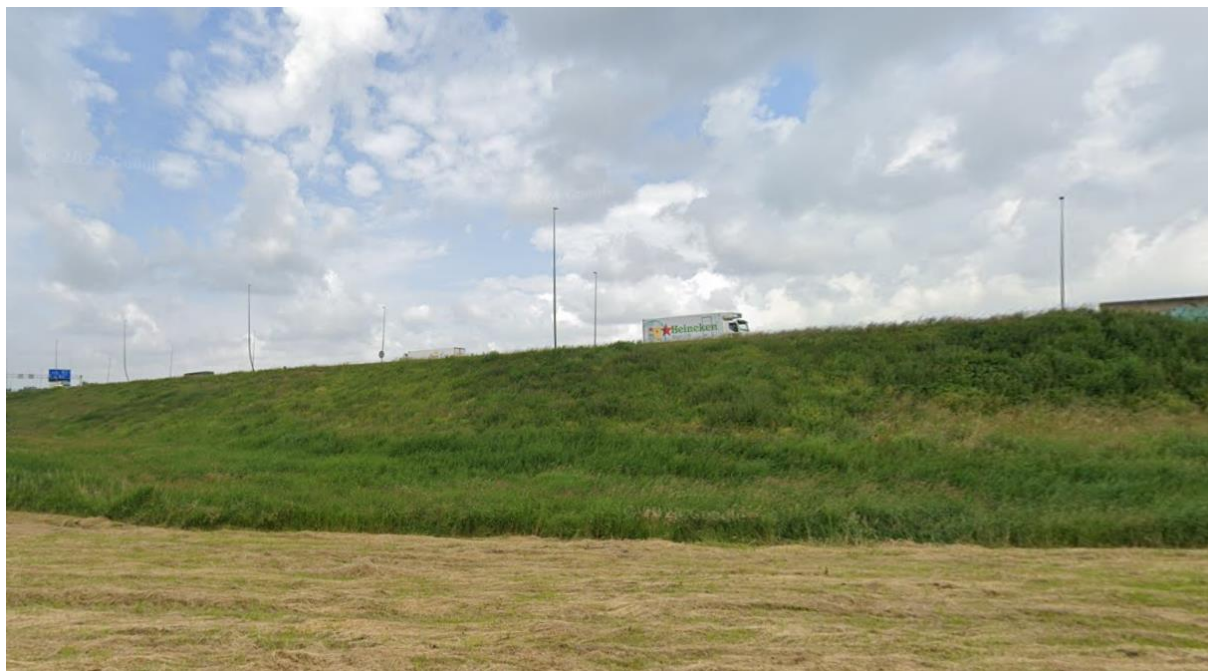
Figuur 7: Projectlocatie 43: zonnepanelen worden aangelegd op de taluds van de A5 (bron: Google streetview)
