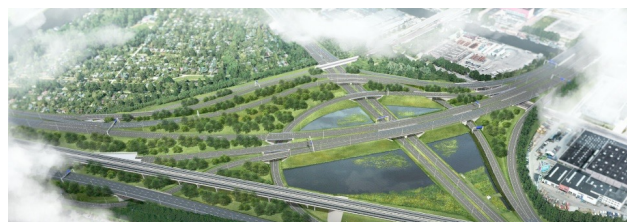
RWS, Reconstructie knooppunt Amstel - Zuidas
