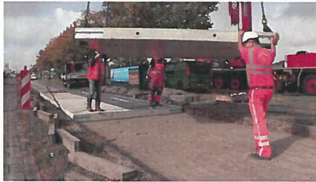
Figuur 6 Living Lab SolaRoad tijdens de aanleg
