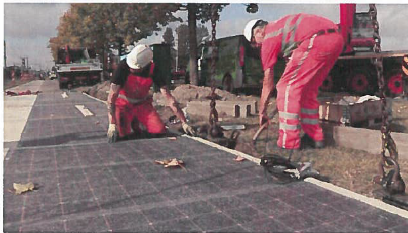
Figuur 10 Foto van element V2 tijdens plaatsing
