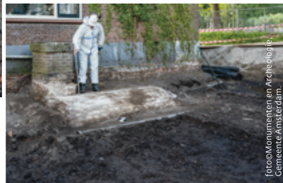
De waterkelder, die nog steeds is verbonden met de dakgoot.
