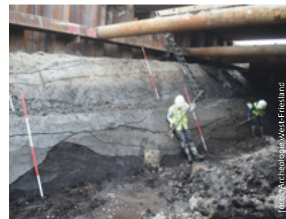
De buitendijkse bouwkuip. Zichtbaar zijn twee vermoedelijke erosiegeulen en overstromingslagen afgedekt door een latere ophoging van de dijk.
