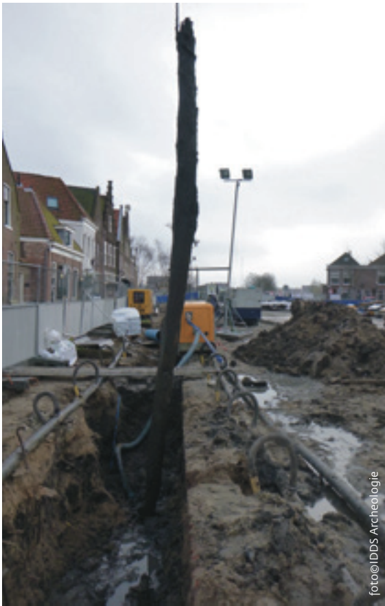
Een voorbeeld van één van de (hei)palen die met het langshout waren gefixeerd.
