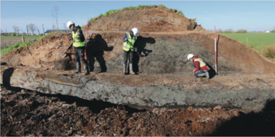
Het profiel door de Stroeërdijk. Links is de voormalige zeezijde, rechts de landszijde. Onder de gelaagde zoden van de oudste dijk is een dik marien pakket van klei en verslagen veen zichtbaar. Aan de linkerzijde wordt het wierpakket opgeschaafd.
