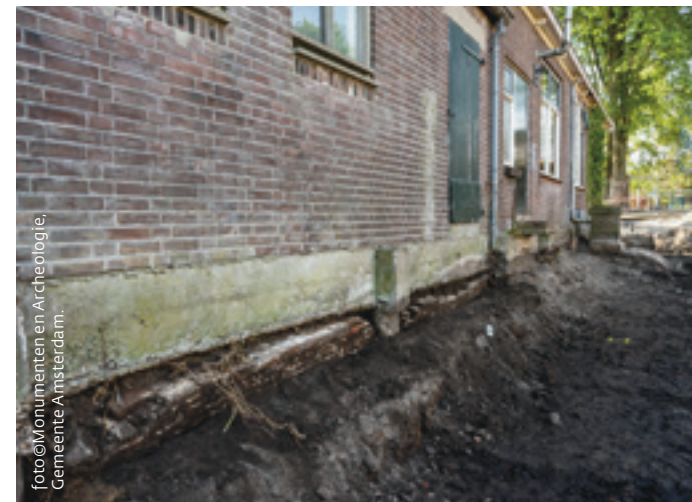
Detail van de noordgevel van de stal, met onder de betonbalk de fundering van de voorganger.
