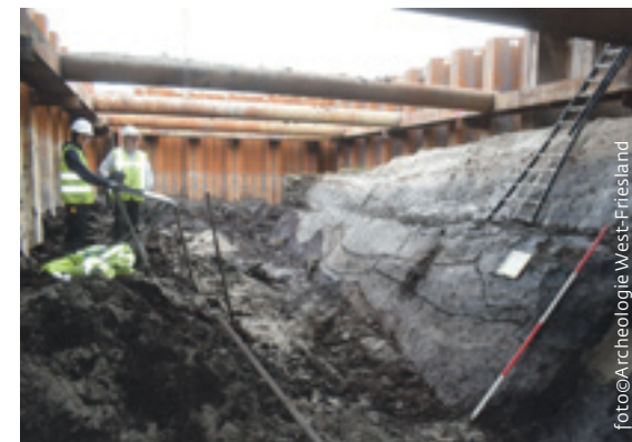
De buitendijkse bouwkuip. Bovenop het natuurlijk gegroeide veen zijn diverse overstromingslagen, erosiegeulen en ophogingen van de dijk te zien.
