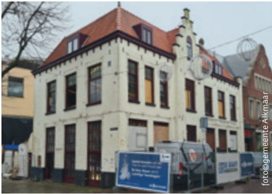
Het Gulden Vlies tijdens de restauratie, met links de sloop van de achteraanbouw (14-12-2021).
