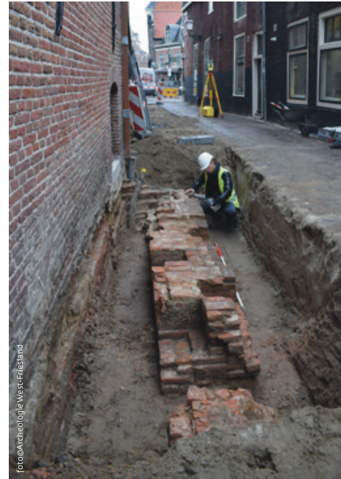
In de Proostensteeg is de fundering van het in 1425 gebouwde Proostenhuis onderzocht. In de muur bevinden zich kaarsnissen.
