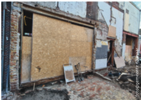
De achterkant van het hoofdgebouw vanuit het noordwesten. Door de sloop van de achterste laagbouw resteert hier van het 'bestaand lokaal' van 1907 slechts een dichtgezet gat met aan weerszijden ervan nog opgaande 15de-eeuwse muurresten.
