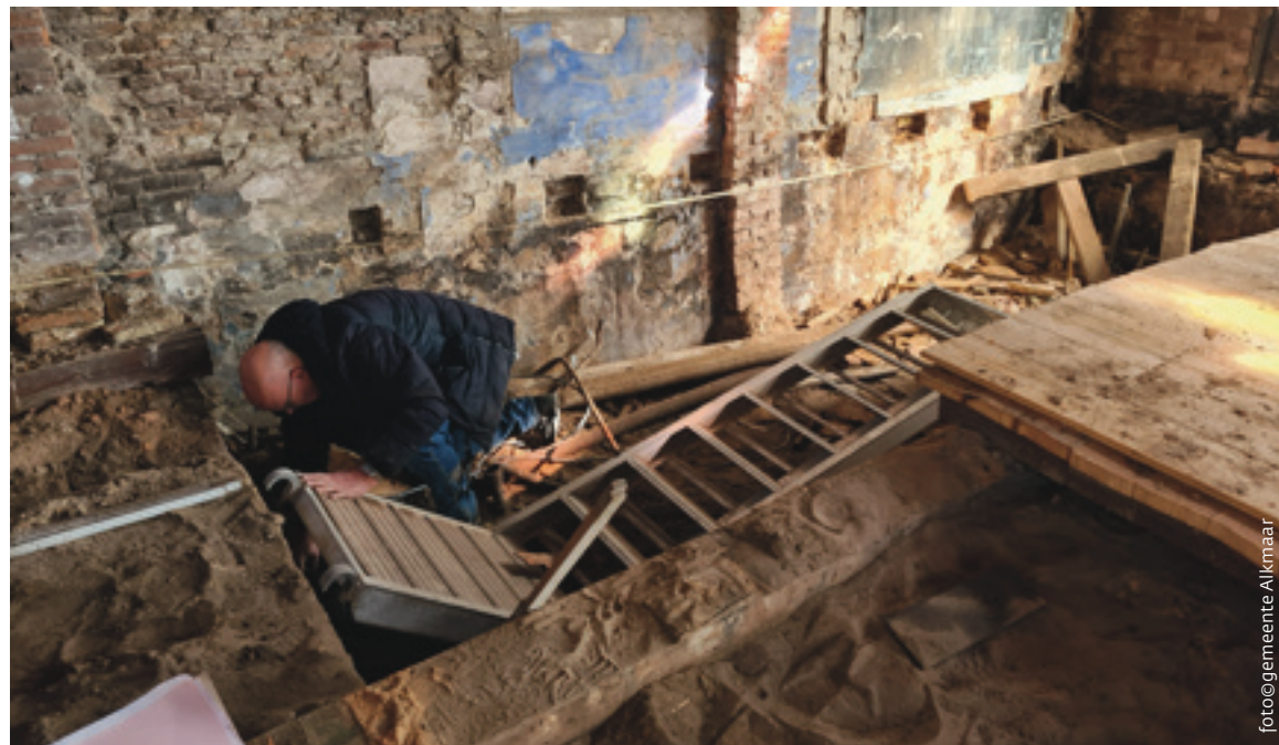
Inpandig onderzoek van een kelder in de noordoosthoek, ontdekt na verwijdering van een deel van de houten vloeren.
