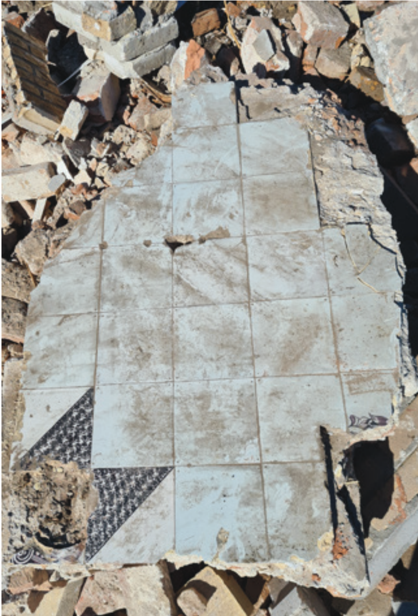
Stuk betegelde haardwand tussen het slooppuin van het voorhuis.
