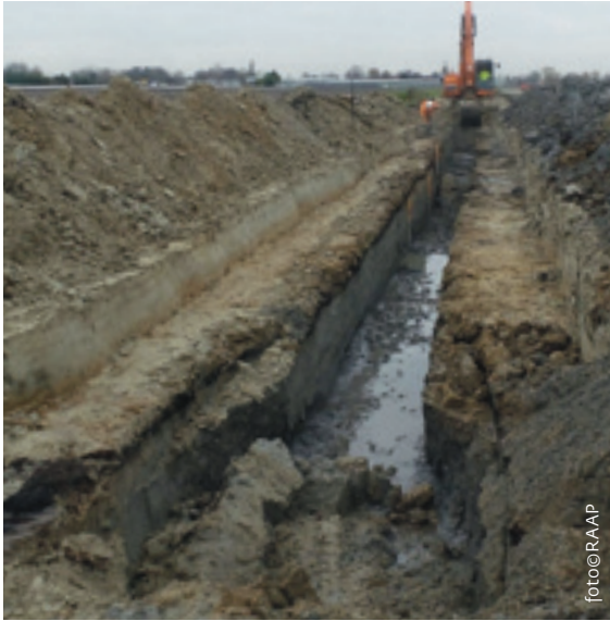
Impressie van het veldwerk: getrapte aanleg van werkput 1.
