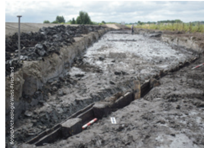
Overzicht van de houten schotten in de zoden van de dijk. Links is de zeezijde, rechts de landzijde. Op de achtergrond wordt de tegenhanger van het schot op de voorgrond ingemeten.
