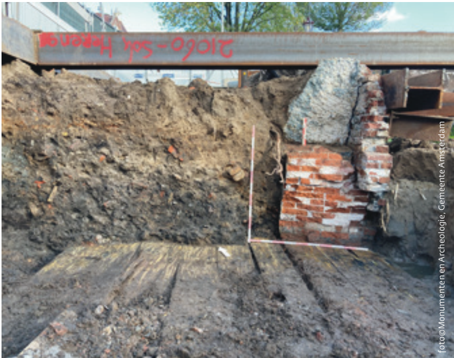
Ter hoogte van de Nieuwe Herengracht kon in een droge werkput de ruime insteek die was gegraven in de 17de-eeuwse ophogingen voor de aanleg van de 19de-eeuwse funderingsvloer in kaart worden gebracht. In de vorige eeuw was dwars door deze insteekvulling opnieuw een werkput gegraven om de top van de gemetselde kademuur af te kunnen breken en te vervangen door beton.
