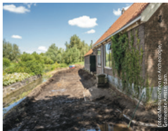
Overzicht van het ontgravingsvlak aan de westzijde van de boerderij, gezien naar het achterterrein. Tegen het huis is het gewelf en de vierkante mond van de waterkelder te zien.
