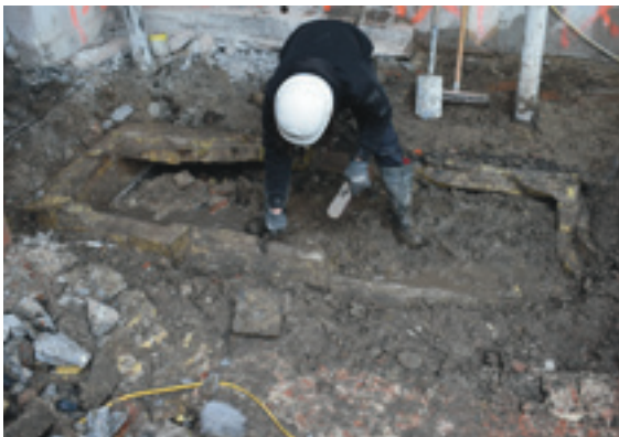
De inpandige waterput is blootgelegd na het wegbreken van een deel van de betonvloer.
