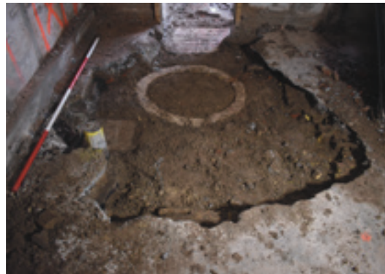
De inpandige waterput is blootgelegd na het wegbreken van een deel van de betonvloer.
