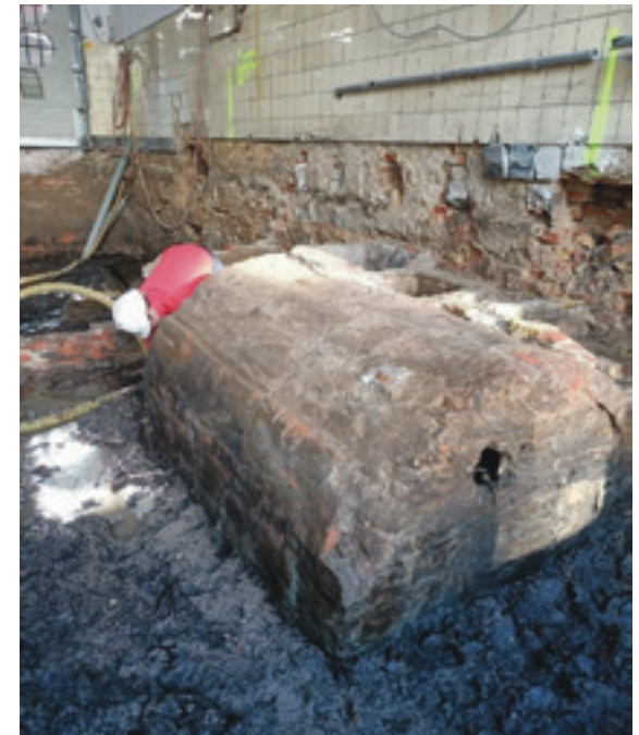
Zijaanzicht van de waterkelder.
