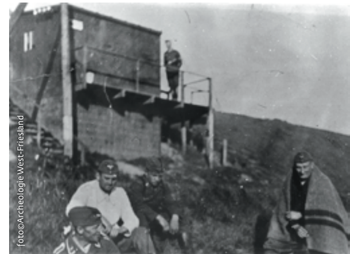
De FluWa op de dijk bij Warder.
