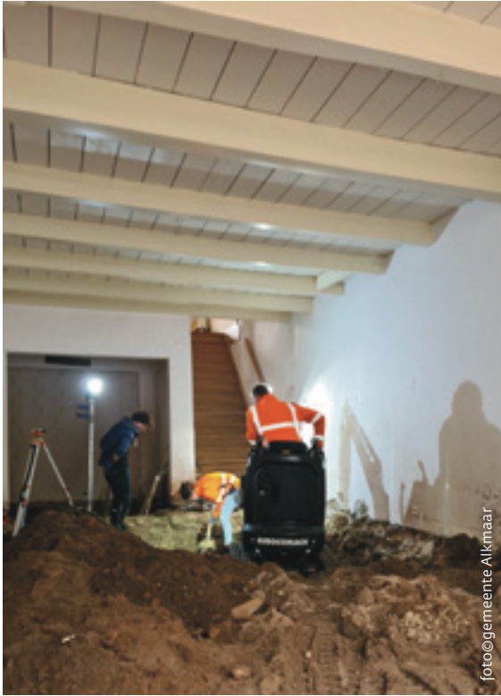
Graafwerk in het achtervertrek met inzet van een kleine graafmachine. In de balklaag erboven is de raveling te zien voor een schouw tegen de zuidelijke zijmuur.
