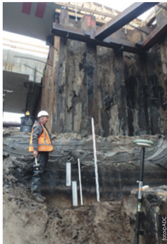
Impressie van de werkzaamheden.
