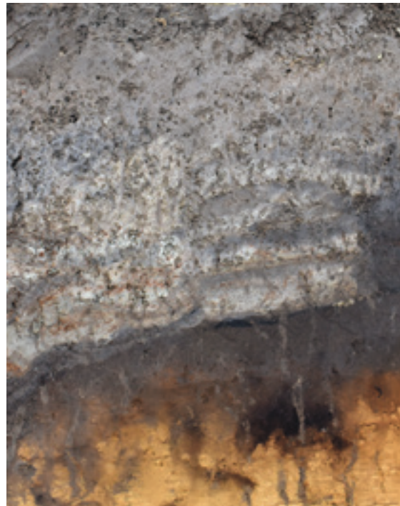
< Detail van de wand uit gestapelde zoden.
