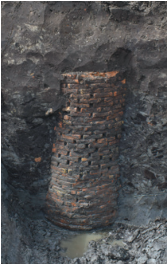
Coupe van de bakstenen waterput.
