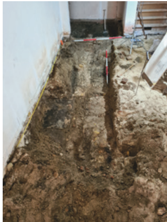
De leemvloeren zijn in de 16de eeuw vervangen door kleine ongeglazuurde rode plavuissjes, waarvan alleen geheel achterin nog een stukje onverstoord was (gezien vanuit het westen). De vloer sluit aan op de oude fundering.
