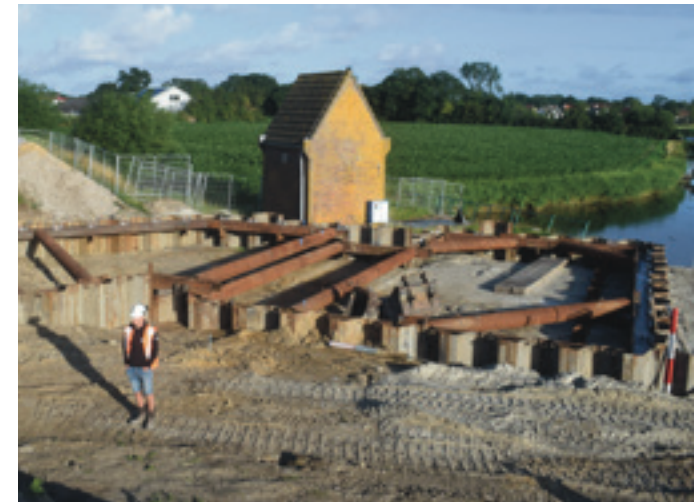
Op de voorgrond de bouwkuip voor het nieuwe gemaal, in het midden het markante gebouw van het huidige gemaal De Hoelm, rechts de kruin van de Hoelmerdijk. De kijkrichting is west, richting De Haukes.
