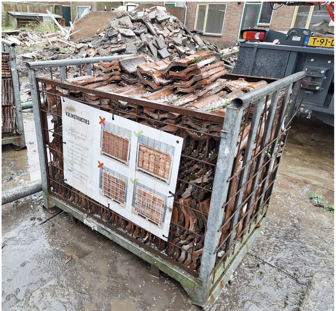
Dakpannen kunnen goed worden geoogst voor hergebruik.
