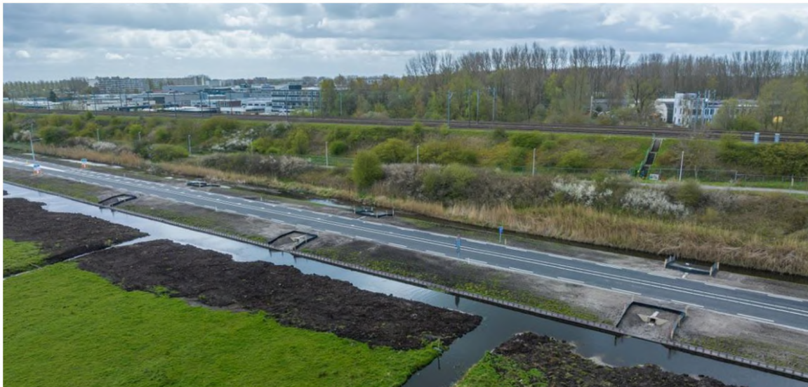
Afbeelding 2.3 Ringslangpassages in Waterlinie (3 stuks)
