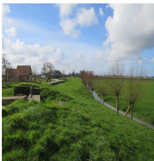
Figuur 9 Boven: de kade naast de Busch en Dam (rechts) is bijna niet herkenbaar. Onder: nevenbatterij met een gedeelte van de dijk dat in 2012 is gereconstrueerd
