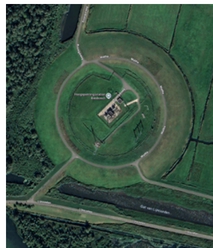
Hoogspanningsstation Biesbosch, Noorderwaard (Zuid-Holland) bron: Google Maps
