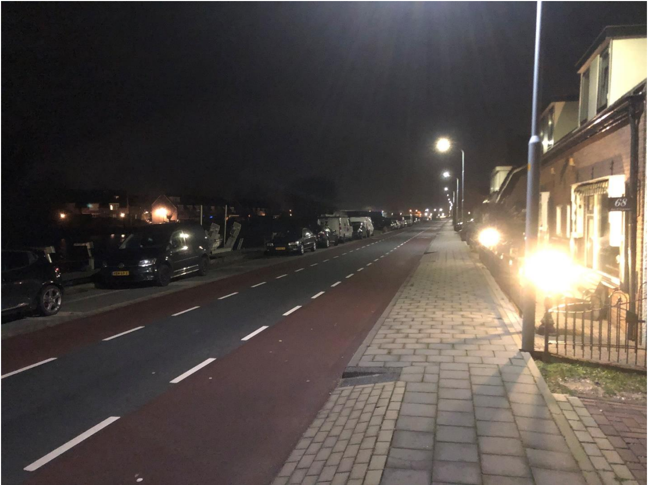
Foto 4: ter hoogte van Hillegommerdijk 68
