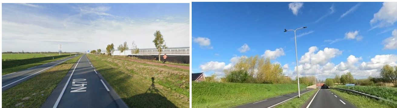
Figuur 27: voorbeeld 2x1 dwarsprofiel gebiedsontsluitingsweg (N470)
