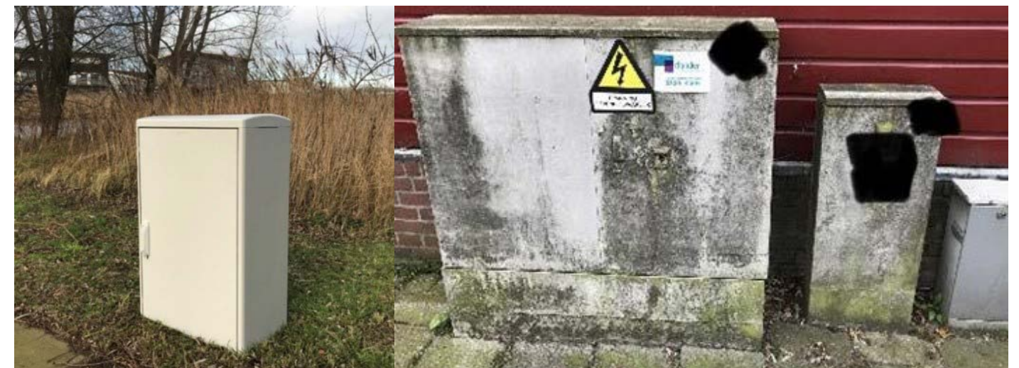
Laagspanningskast (wijkkasten/straatkasten)
