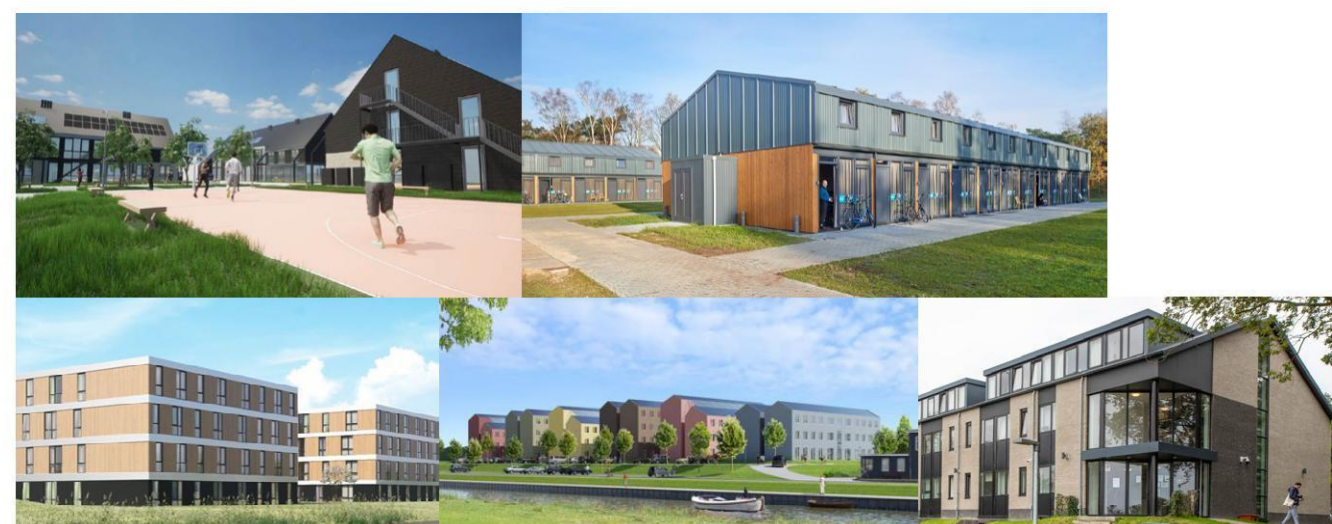
Voorbeelden hoogwaardige huisvesting Arbeidsmigranten
