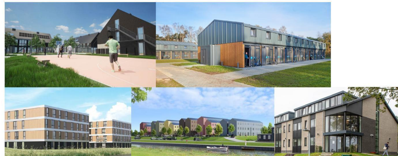
Voorbeelden hoogwaardige huisvesting Arbeidsmigranten
