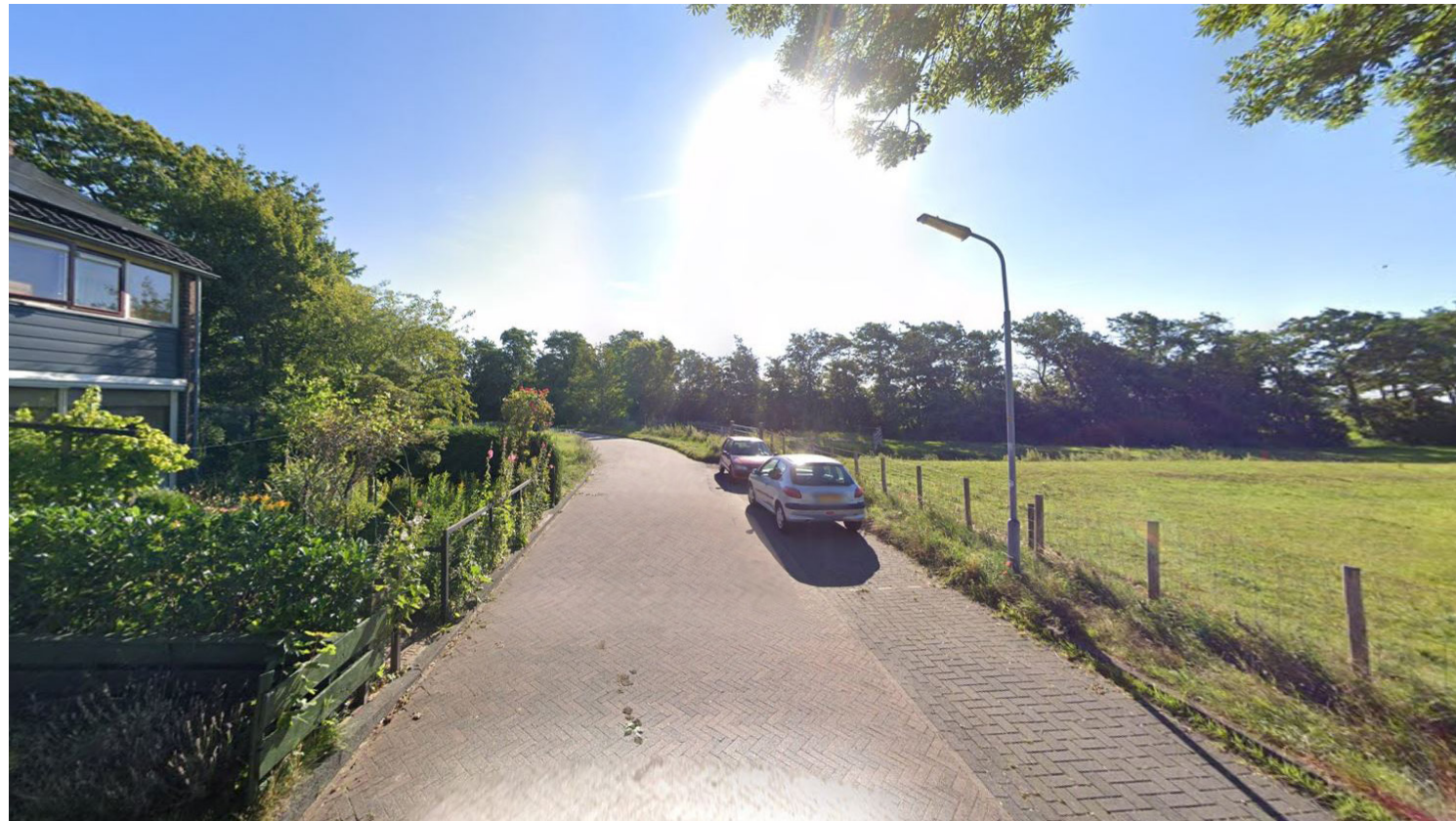
plangebied vanaf westen (J.M. Graadt van Roggenweg, zomersituatie)
