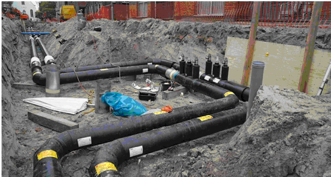
Figuur 8 Voorbeeld van warmtenet in aanleg.
