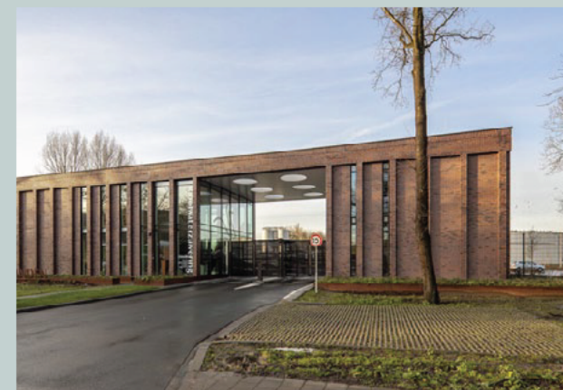
uitnodigende losstaande entree
