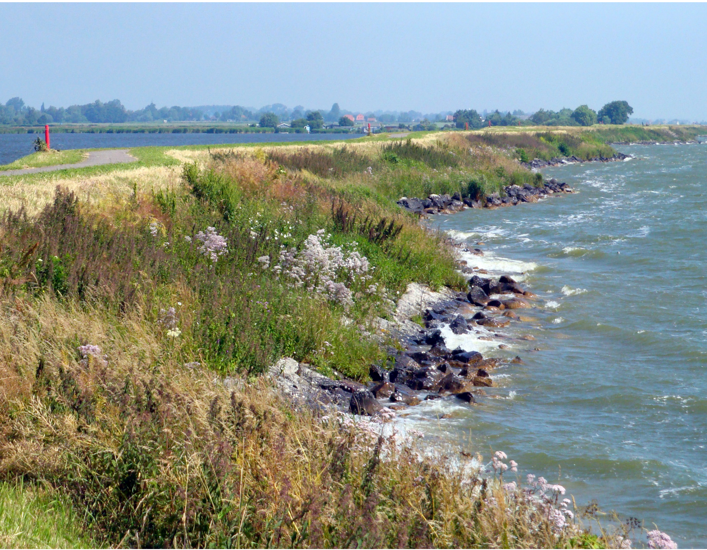
Karakteristiek tracé van de Uitdammerdijk (module 15)
