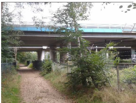
Figuur 3.6 Faunapassage onder de A27 en ten zuiden van het spoor
