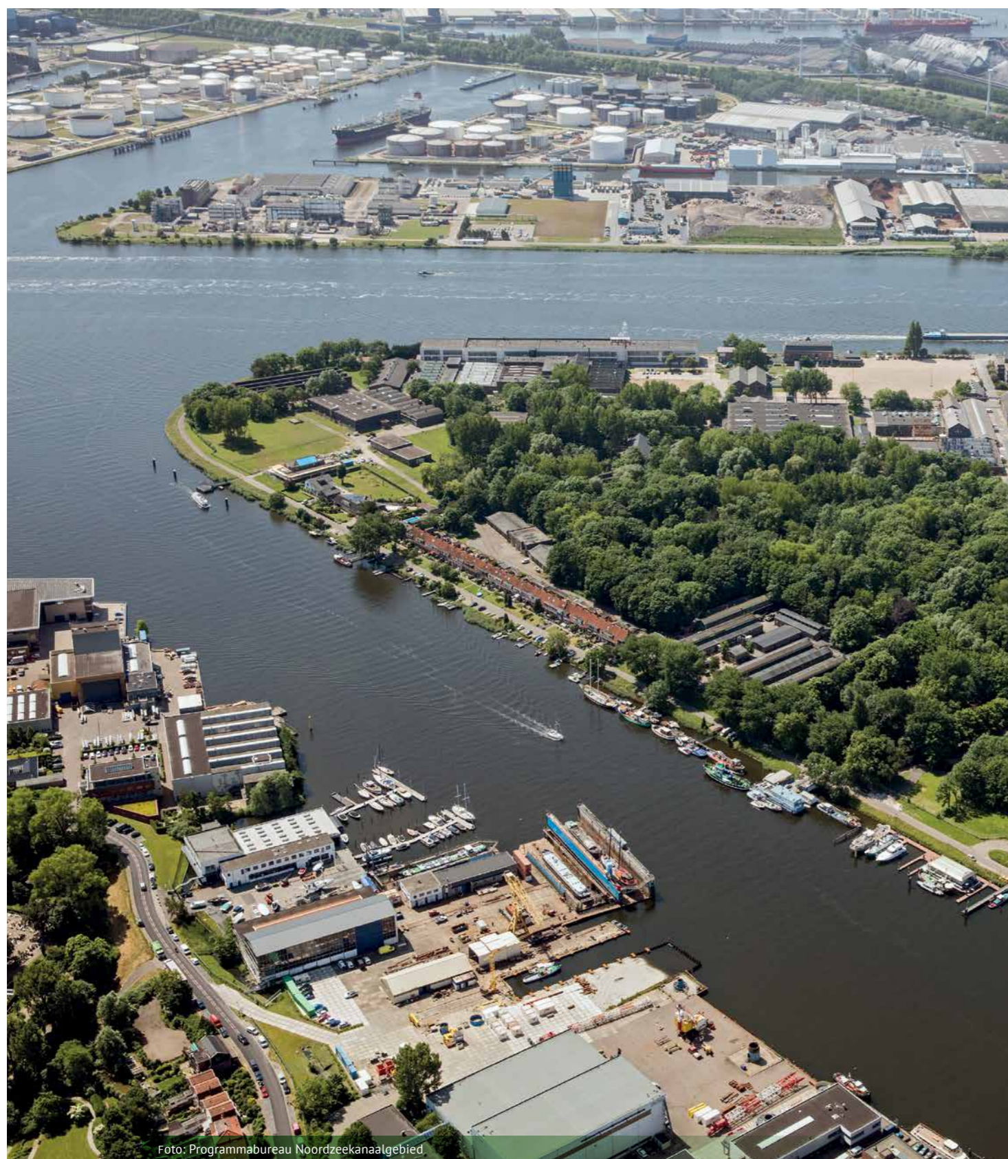
Foto: Programmabureau Noordzeekanaalgebied
