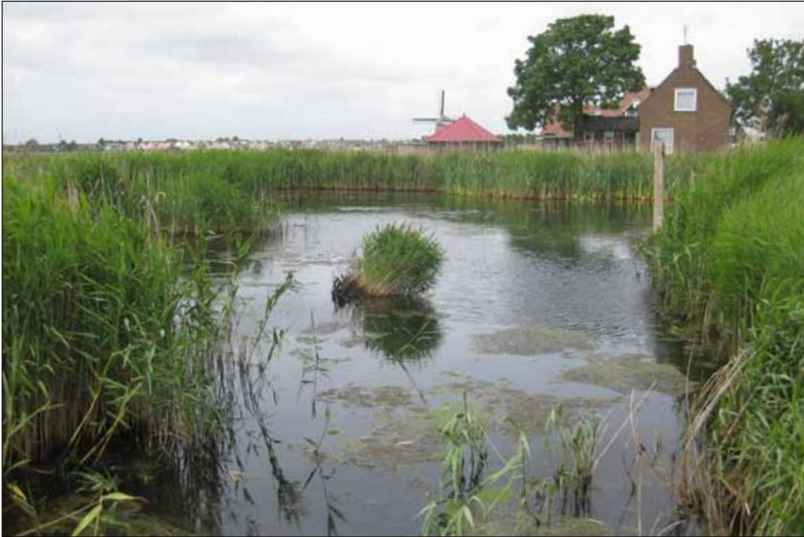
Afb. 9.20 De braak tussen Hoogedijk 59 en 60, gezien richting het noorden.
