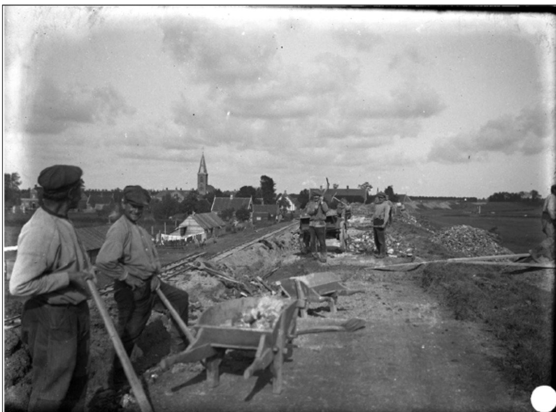
Afb. 8.12 Foto van de dijkversterking bij Scharwoude in ca. 1921 (collectie WFA). Op de achtergrond de kerk van Scharwoude. Links de voor de werkzaamheden aangelegde spoorrails. Het puin (de oude wegverhardingen) in de kruin van de dijk wordt handmatig verwijderd.
