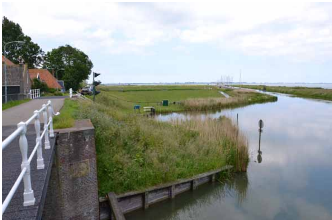
Afb. 9.14 Uitzicht op het buitendijkse land de Floriskoog vanaf het sluisencomplex in Schardam. Gezien richting het noorden.
