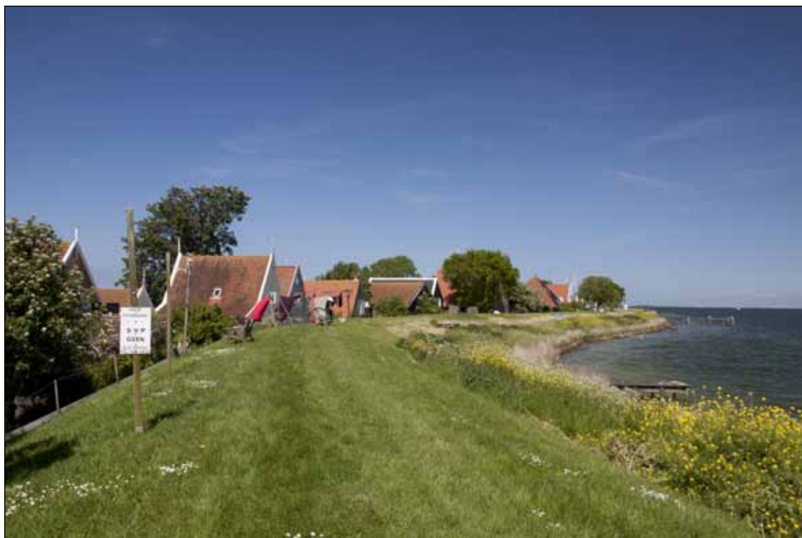
Afb. 9.35 Uitdam gezien vanaf de dijk, kijkend richting het noordoosten.
