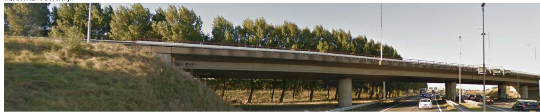
viaduct knooppunt A9-A22
