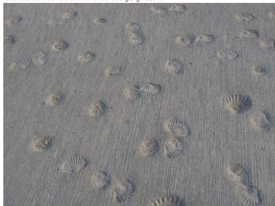
Referentiebeelden betonwerk onderdoorgang Kilzone
