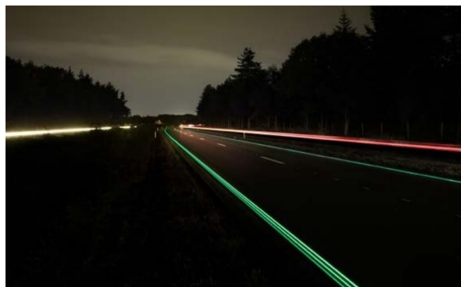
N329 Glowing Lines: Actieve markering door glow-in-the-dark belijning
