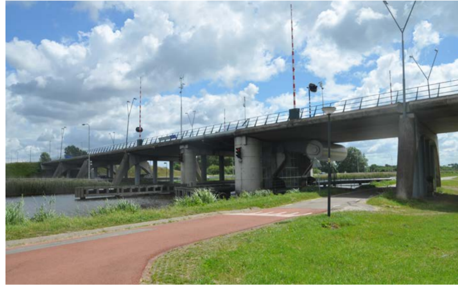
hergebruik bestaande brug Nauenasche Vaart voor één rijrichting als voorbeeld van duurzaam ruimtegebruik
