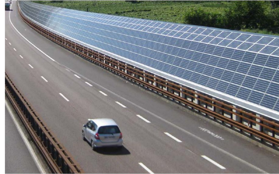
zonnepanelen op geluidschermen als voorbeeld van duurzame energie
