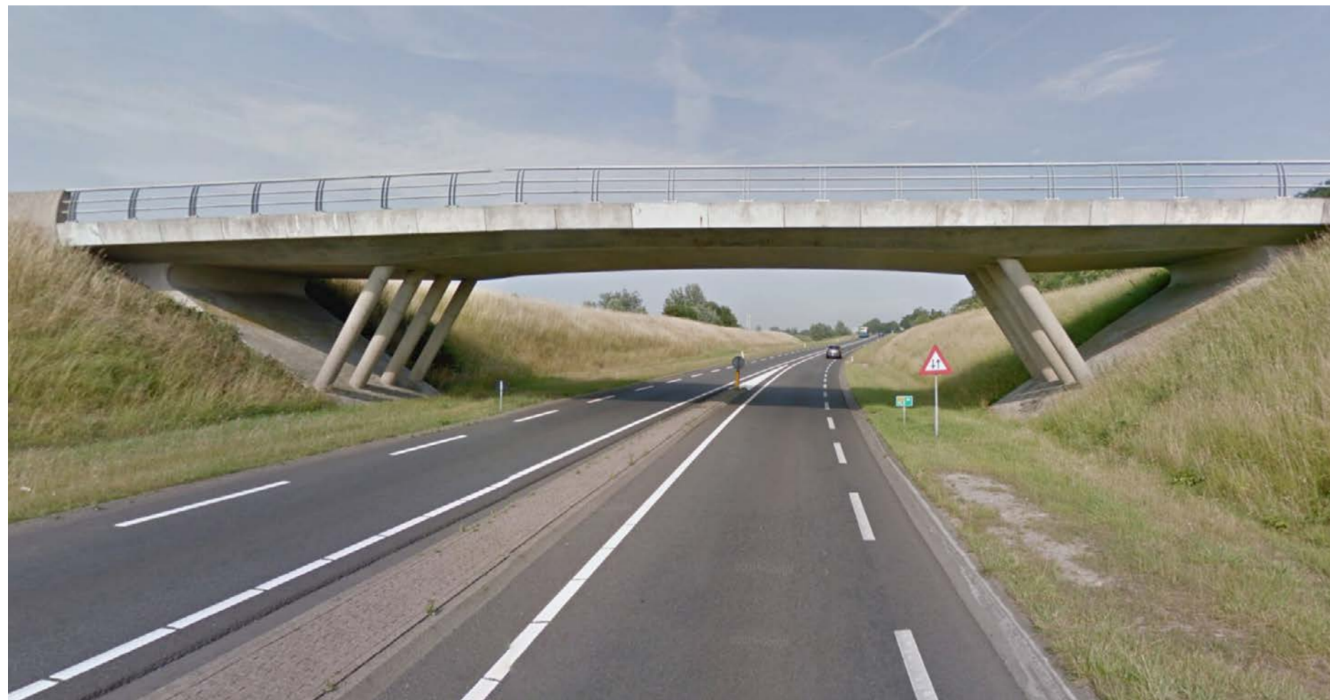
Referentie: springwerkviaduct Wieringen, luchtig door open ondersteuningen
