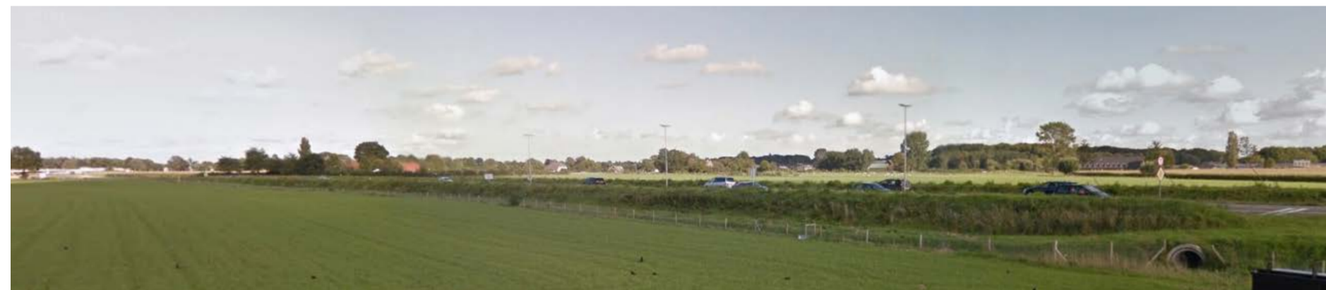
Referentie: grondwal langs N348 tussen Leuvenheim en Dieren, en tussen Eefde en Zutphen
