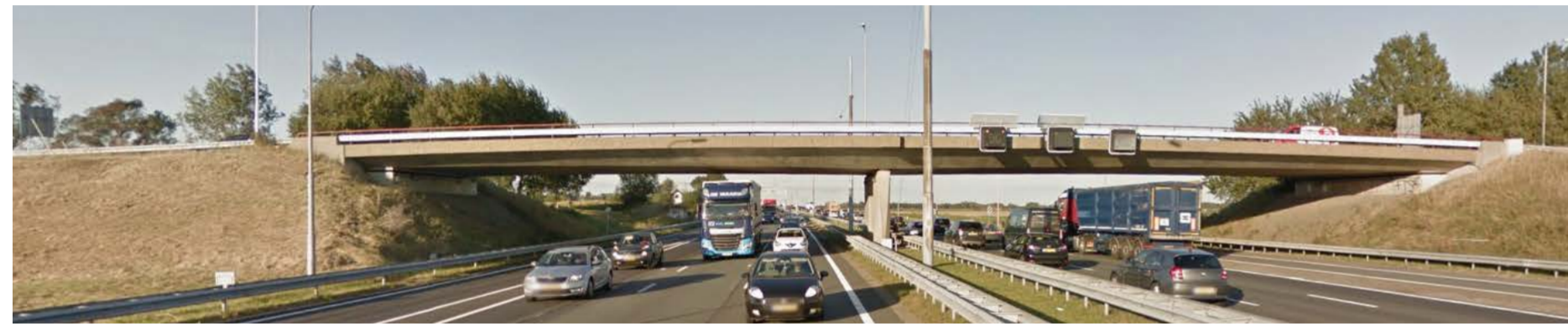
viaduct N246 beverwijk
