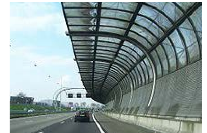
Geluidsscherm als luifel biedt mogelijkheden voor zonnepanelen
