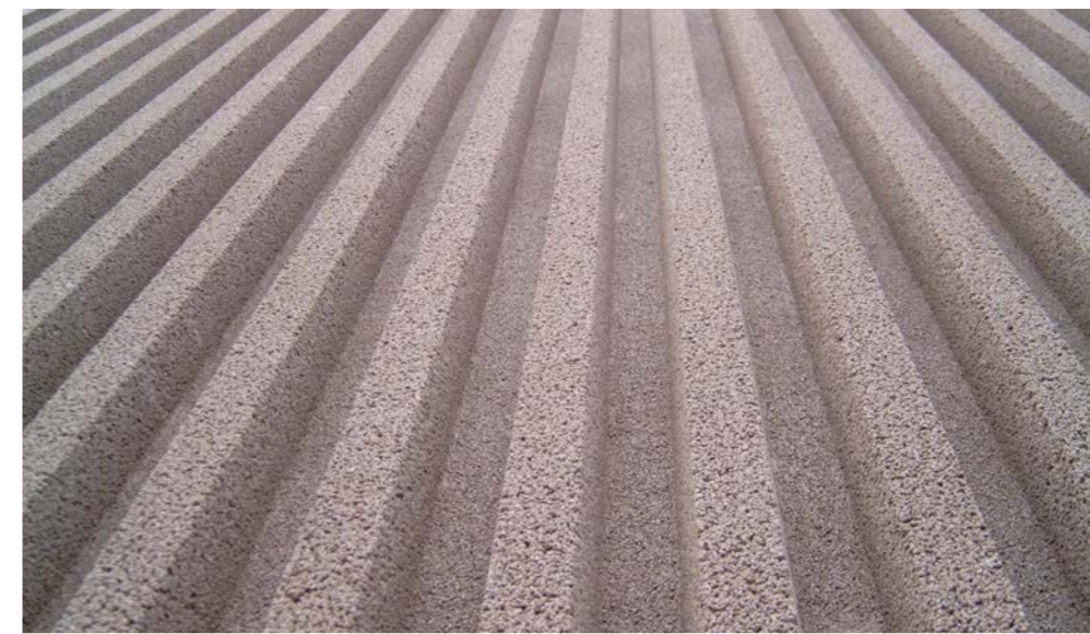
Ruwe geluidsdempende wanden langs het spoor
