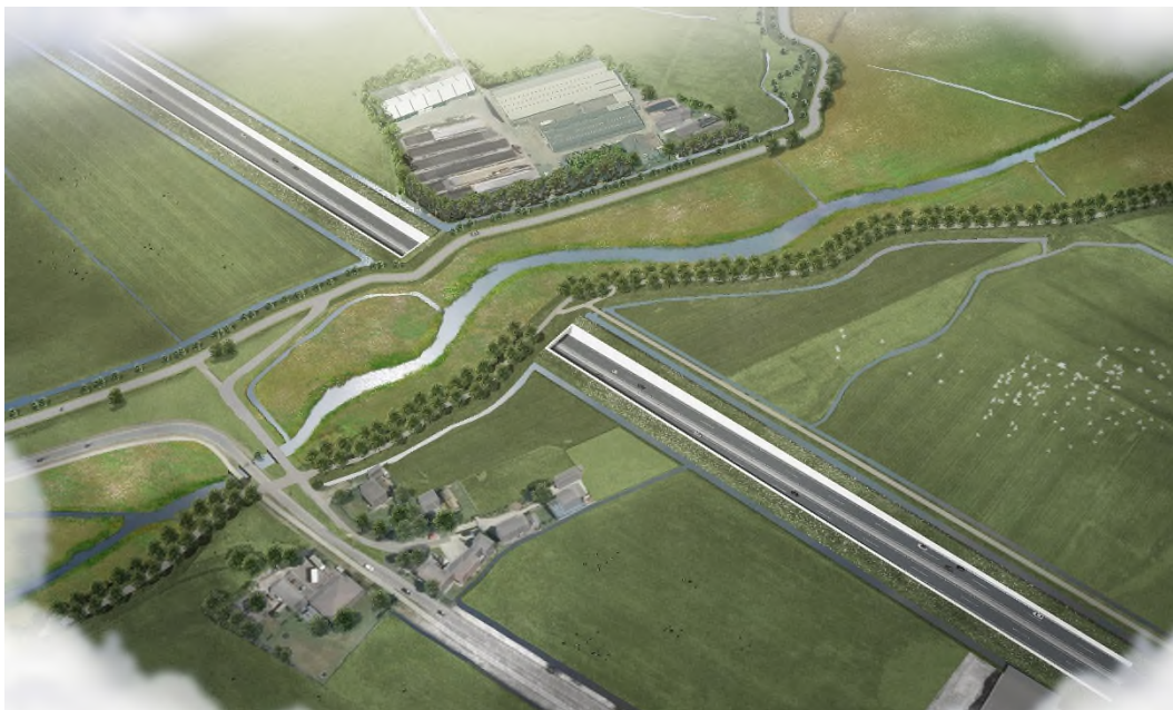
Figuur 3.11: Onderdoorgang Kilzone [Bosch en Slabbers, 2017]
